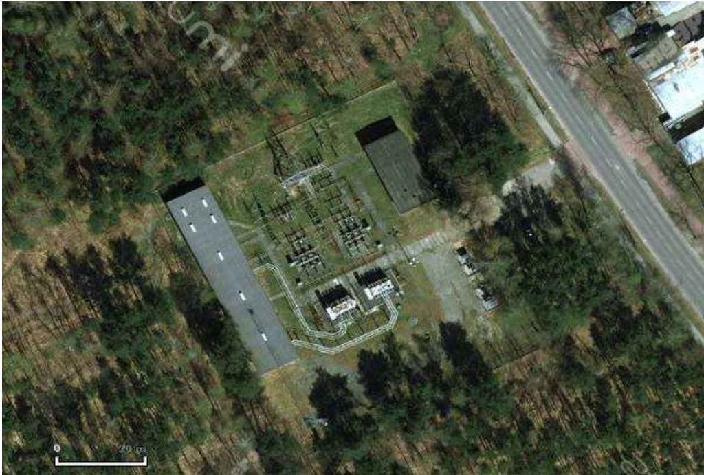
Rys. 1. Układ stacji RPZ Międzyzylesie.
